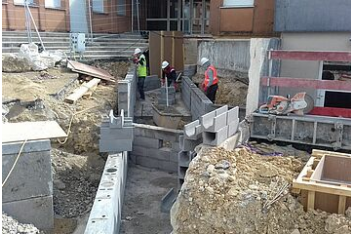
Travaux des collèges
