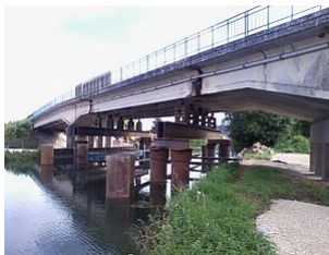
Pont franchissant la Meuse à Void Vacon
