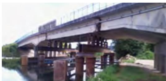
Il était devenu primordial de renforcer et de sécuriser le pont au-dessus du canal de la Marne au Rhin à Void-Vacon, en confortant notamment son tablier. Ce confortement a permis d'autoriser à nouveau son usage par les poids-lourds jusqu'au travaux définitifs.
