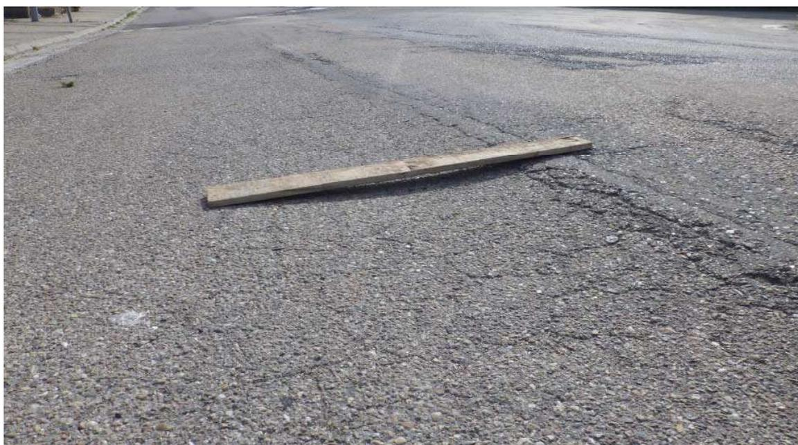
*Illustration 3: Déformations au dessus du réseau d'assainissement*
