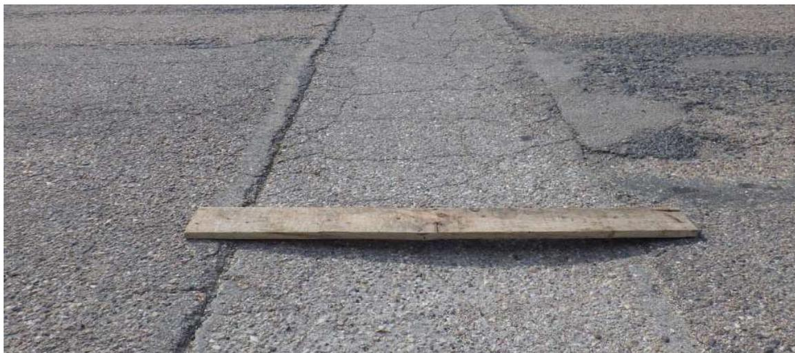
*Illustration 4: Déformation au niveau d'une fouille transversale*
