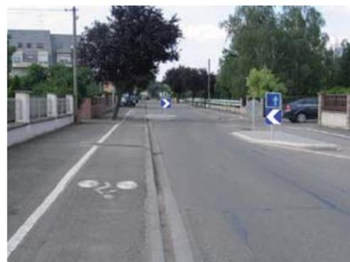
**L'ÉCLUSE** (dans le respect des recommandations du «guide des chicanes et écluses sur voiries urbaines» du CERTU d'avril 2012)
