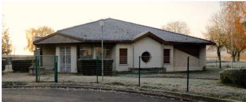
Le bâtiment d'accueil de la gendarmerie (non concerné par les travaux / réserve foncière)
