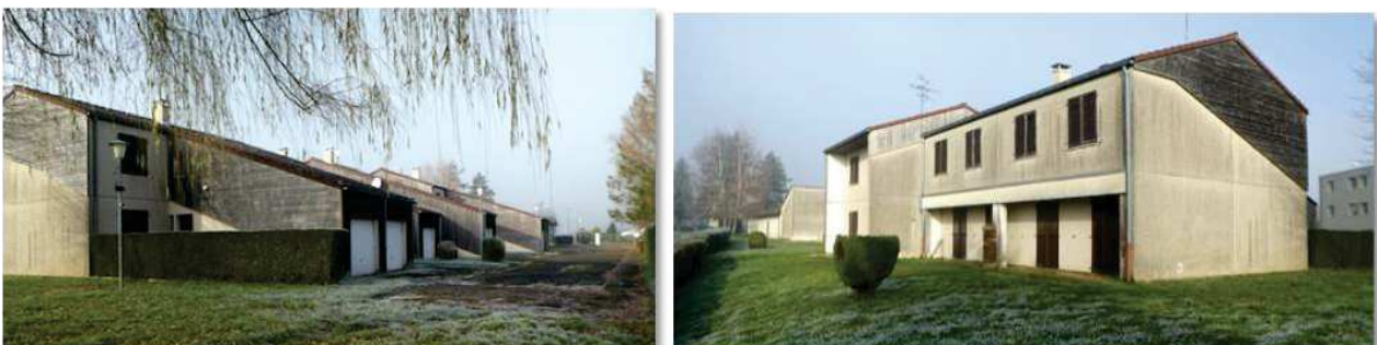
Le bâtiment d'habitation, objet du projet
