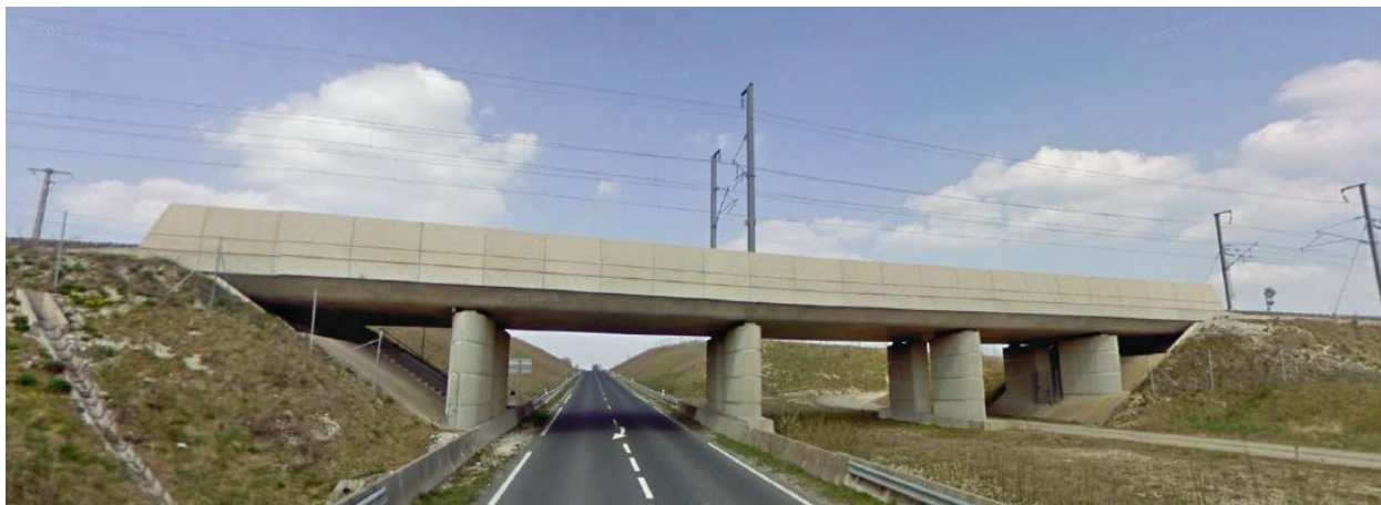
Ici, Réseau Ferré de France est propriétaire de l'ouvrage supportant la LGV sur la route départementale Voie Sacrée.
