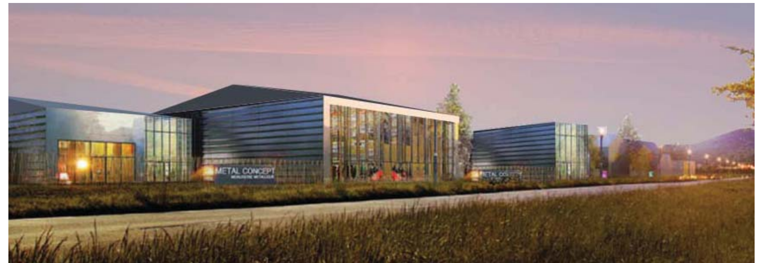
Des formes de bâtiments simples
