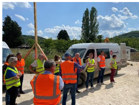
Figure 27 : Visite de chantier l'après-midi
