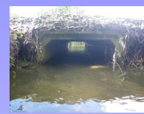
Mise en place d'un pont cadre
